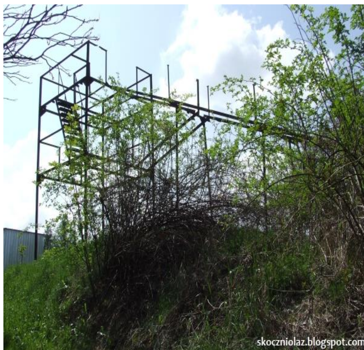
Fot. 29. Pozostałości po skoczni w Krośnie (metalowy szkielet konstrukcji rozbiegu)
